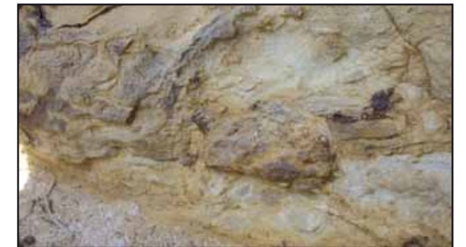
Superficie in gneiss minuto completamente degradata con larghe e irregolari cavità superficiali
